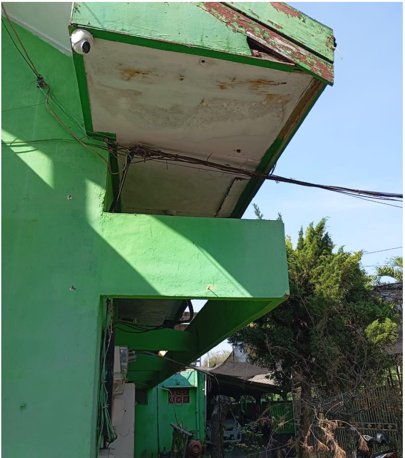
CCTV Tempat Parkir
